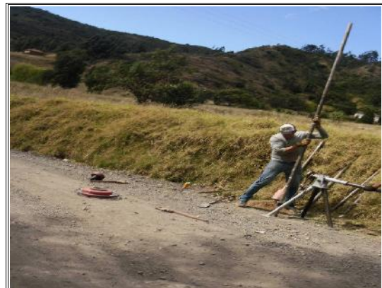
FOTOS SONDEO No - 1
