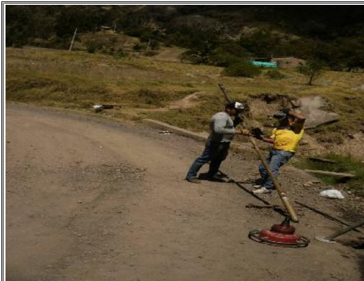
FOTOS SONDEO No - 1
