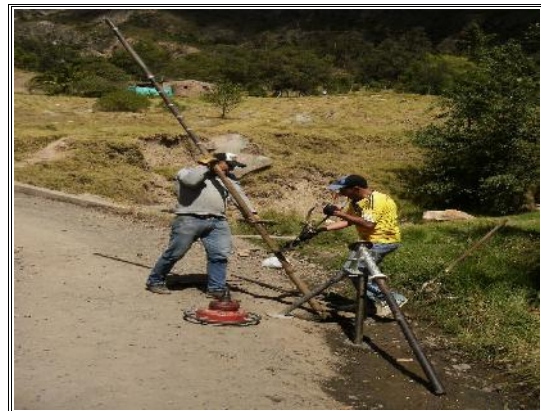
FOTOS SONDEO No - 2
