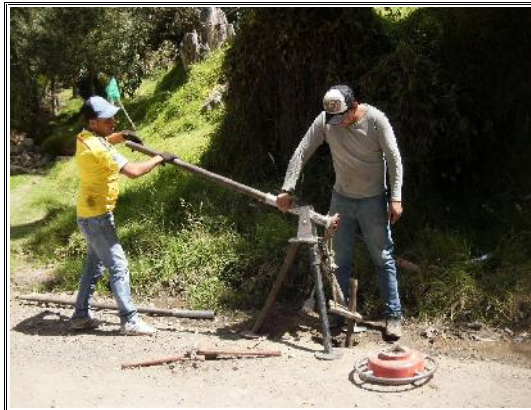
FOTOS SONDEO No - 2
