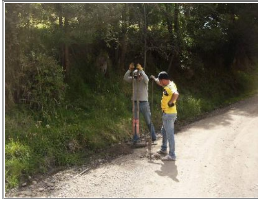
FOTOS SONDEO No - 2
