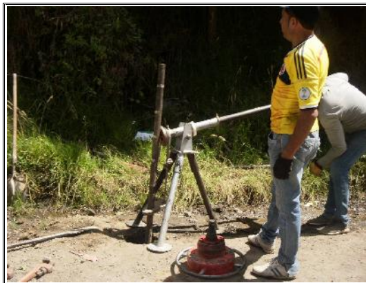
FOTOS SONDEO No - 2
