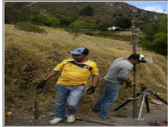
FOTOS SONDEO No - 1
