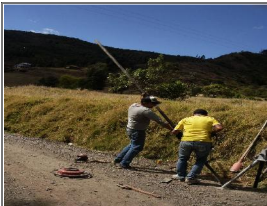
FOTOS SONDEO No - 1
