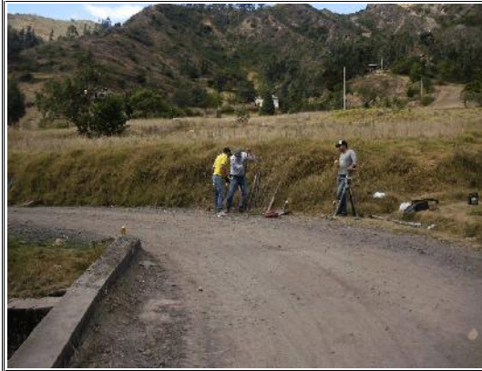
FOTOS SONDEO No - 1
