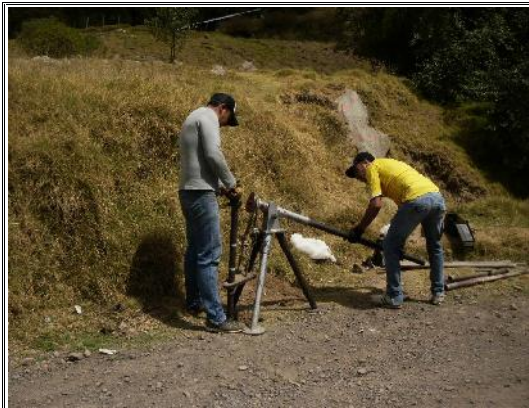
FOTOS SONDEO No - 1
