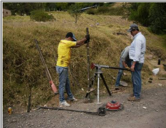
FOTOS SONDEO No - 1
