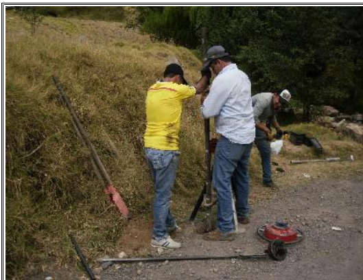
FOTOS SONDEO No - 1
