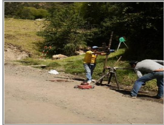
FOTOS SONDEO No - 1
