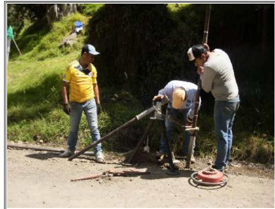
FOTOS SONDEO No - 2
