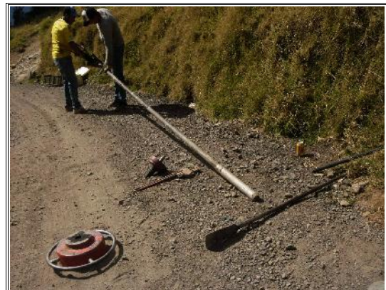
FOTOS SONDEO No - 1
