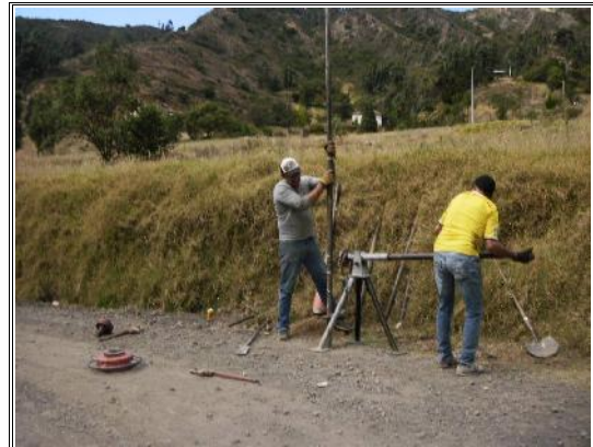
FOTOS SONDEO No - 1
