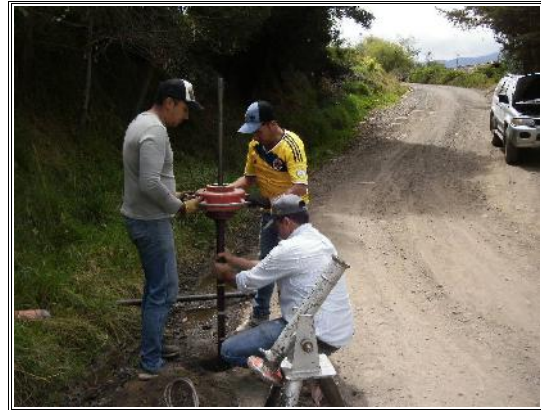
FOTOS SONDEO No - 2
