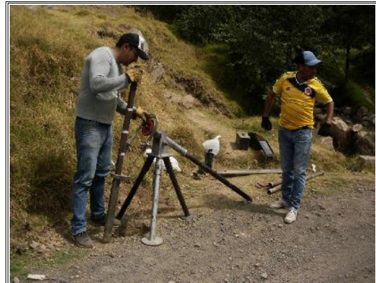
FOTOS SONDEO No - 1
